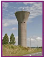
Réservoir sur tour de Goderville 450 m 3
